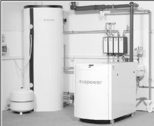
Ein Mini-Blockheizkraftwerk im Keller eines Wohnhauses.
